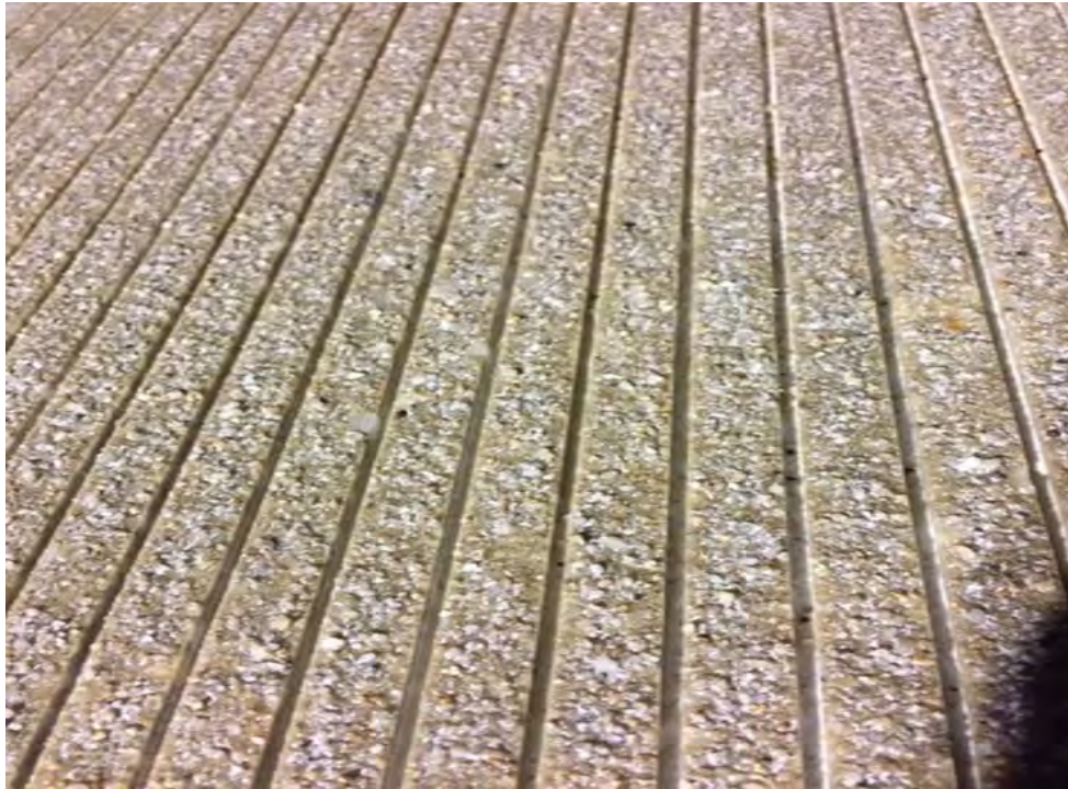
558.02 - Longitudinal Saw-Cut Grooving
