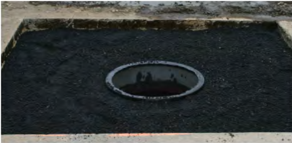
Step 2: Backfill Guide Frame
