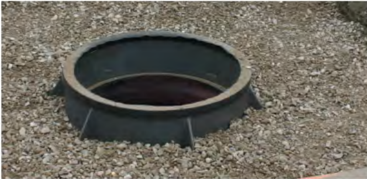
Step 2: Backfill Guide Frame
